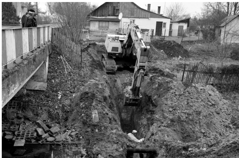
Budowa kanalizacji, przekop pod Gdolaną
